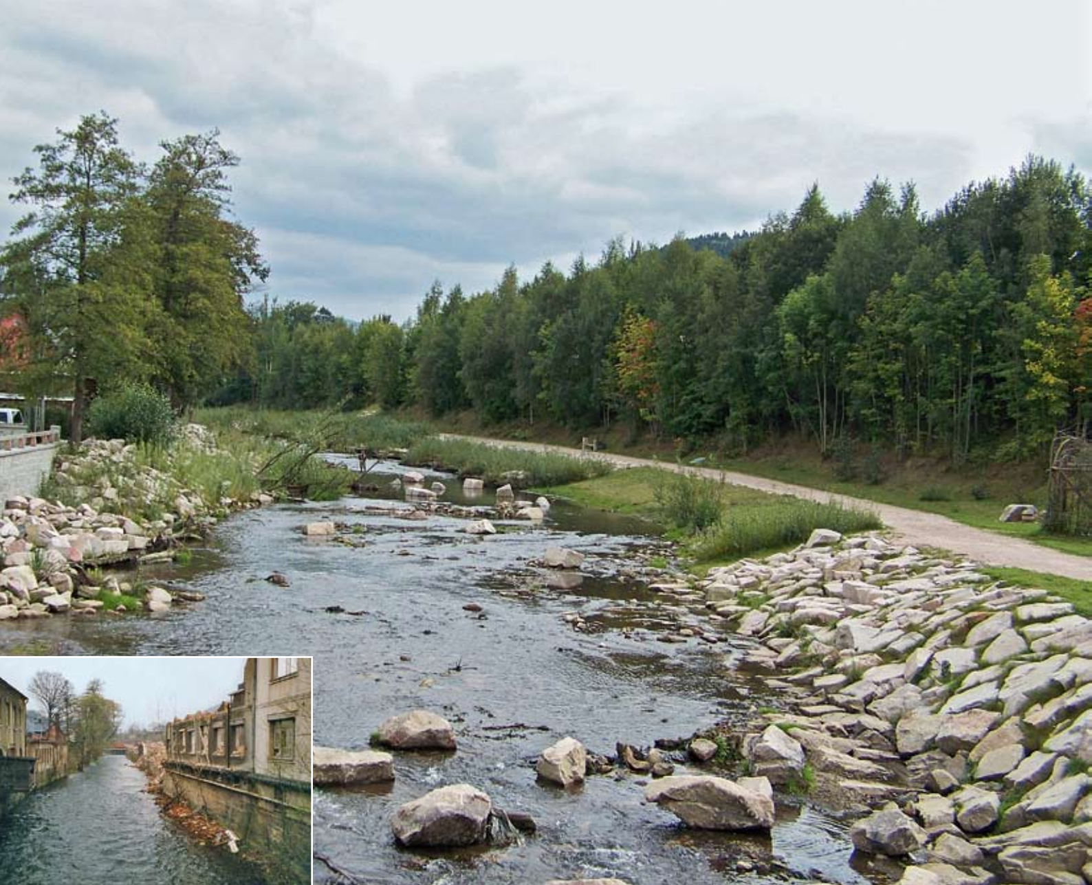
Bei der naturnahen Umgestaltung der Großen Mittweida in Schwarzenberg kamen 15 verschiedene ingenieurbio­logische Bauweisen zum Einsatz. Das kleine Bild links zeigt den Flussabschnitt vor seiner Renaturierung – naturfern, mit begradigtem Gewässerverlauf
