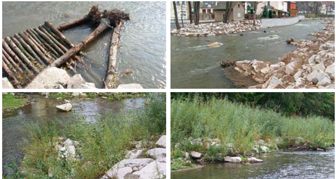
Ufersicherung und -strukturierung durch Baumbuhnen mit Holzrost als Fischunterstand – im Bild links oben während der Bauphase, rechts oben nach Fertigstellung und unten nach einer Vegetationsperiode
