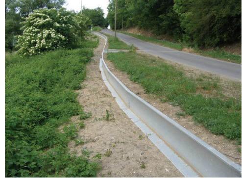
Maßnahme A 26: Stationäre Amphibienschutzanlage Robisch (Los 2) im Juni 2008
