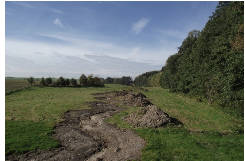
Oktober 2012: Wiederherstellung des Wiesengrundbachs in seinem ehemaligen Verlauf, Erdarbeiten begrenzen sich auf Abziehen des Oberbodens und Herstellung eines flachen Gewässerprofils
