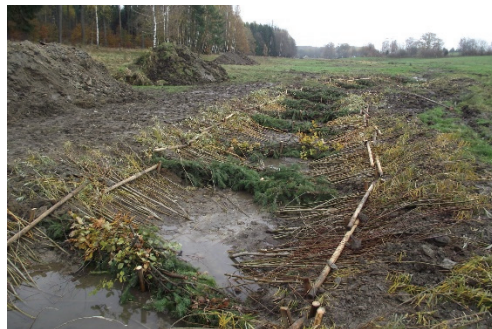
Überwindung eines Gefälleabschnittes mittels Faschinenrampe im Bau, November 2012
