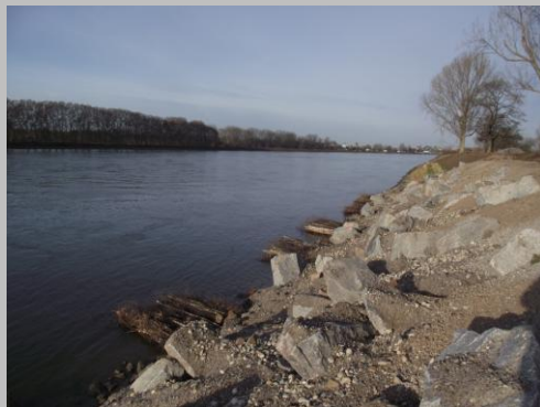
Fischunterstände aus Totfaschinen
