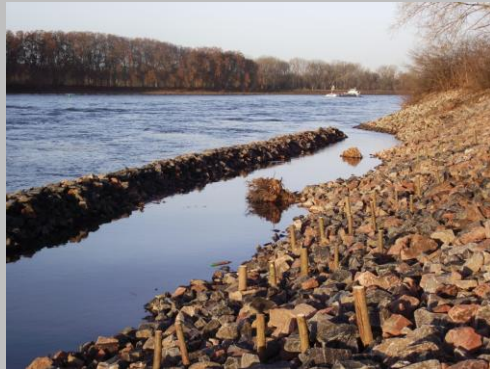
Setzstangen in Steinschüttung
