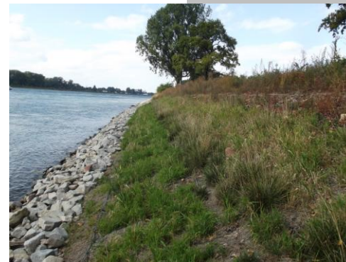
Anwuchserfolg in der Wellenschlagzone
