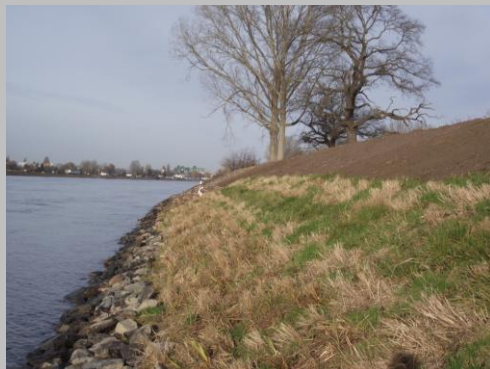
Röhrichtgabionen mit Pflanzmatten
