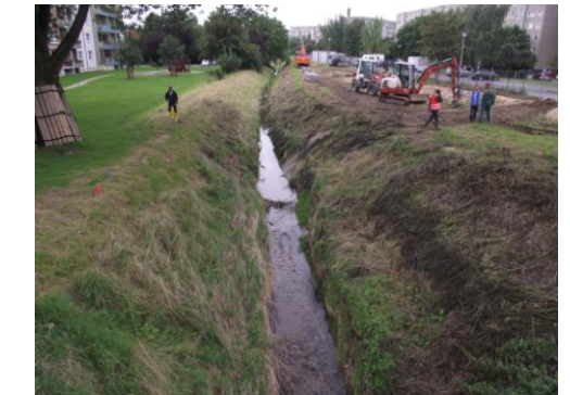
August 2011, naturnaher Gewässerverlauf vor Beginn der Maßnahme
