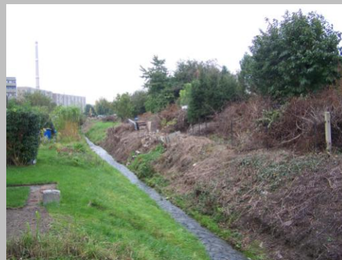
Oktober 2010; Baufeld 2.2; Wilder Uferverbau
