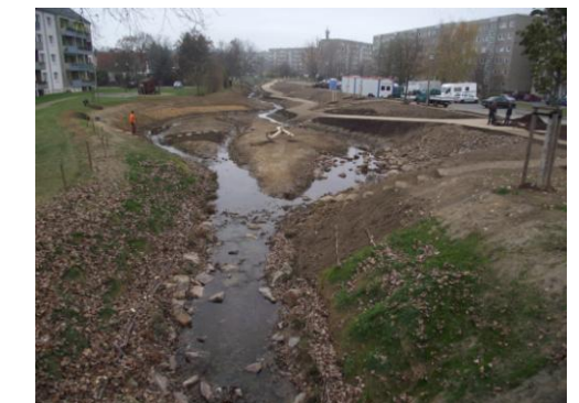
November 2011, Abschluss der Bauarbeiten, die Aufweitung des Gewässerprofils mit einem Wasserspielplatz schafft zusätzliches Retentionsvolumen innerhalb des Gewässerprofils
