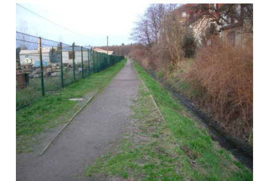
Februar 2005, naturferner Gewässerverlauf vor Beginn der Maßnahme
