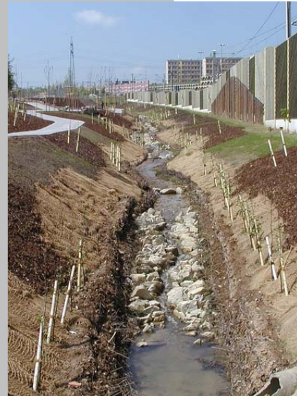
Nach Bauende (Mai 2001)
